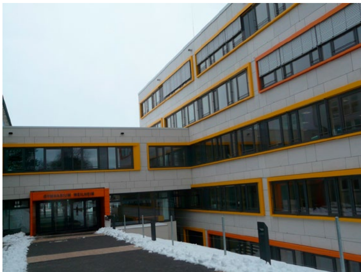
Neugestalteter Zentralbau und Verwaltungstrakt
